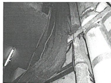
Conductos agua de condensados conductos líquidos refrigerante vista de proximidad con otras instalaciones
